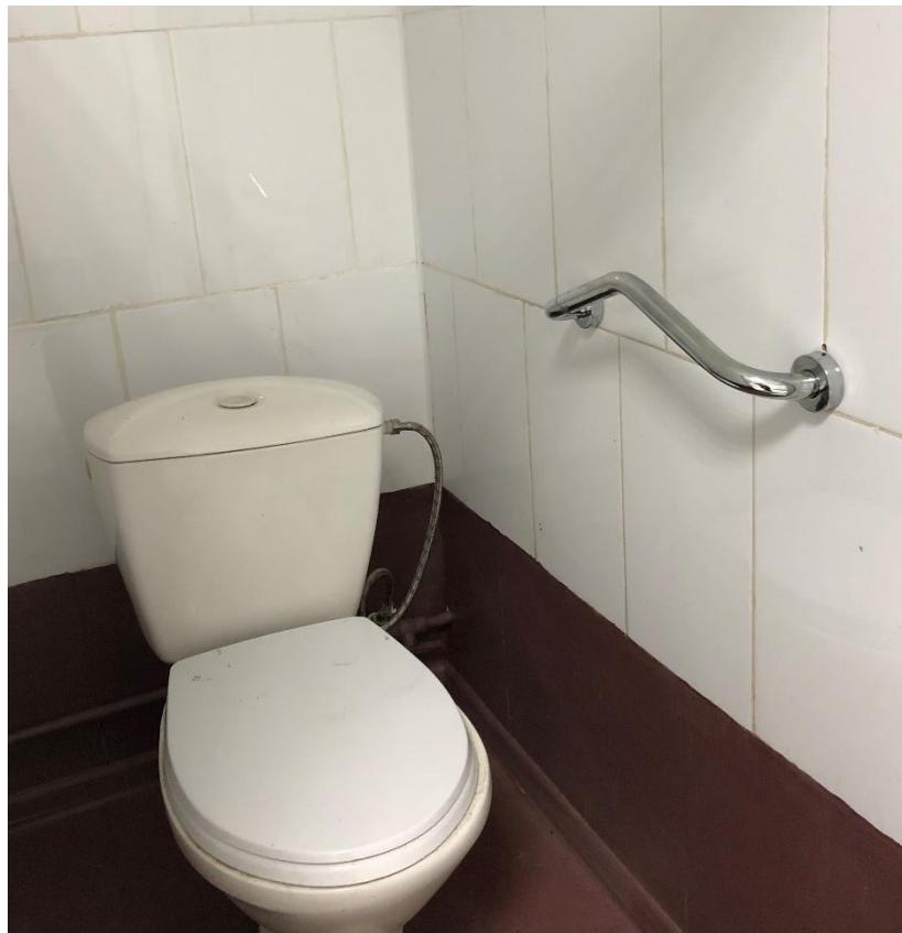
Люди с проблемами опорно-двигательного аппарата используют эти конструкции при перемещении по ровным и наклонным плоскостям, а также в качестве опоры в санитарно-гигиенических комнатах.
